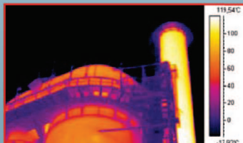
Verifica refrattario in acciaieria
